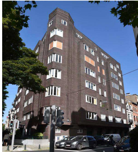
Figure 1 : Vue des façades extérieures de l'immeuble (APEB, « Immeuble à appartements Avenue Molière 210 à Ixelles, Etude historique et matérielle des parties communes », Volume II : illustrations, p. 24, juin 2017)
