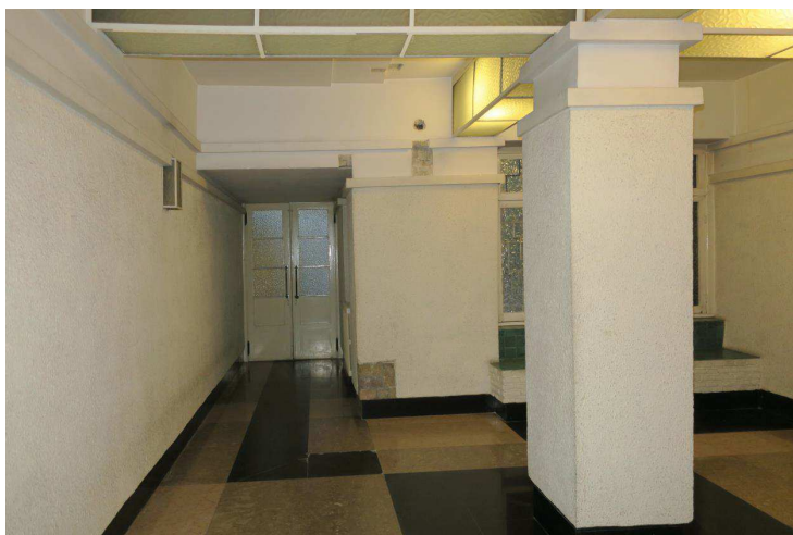
Figure 3 : Vue actuelle de l'intérieur du hall d'entrée au rez-de-chaussée (APEB, « Immeuble à appartements Avenue Molière 210 à Ixelles, Etude historique et matérielle des parties communes », Volume II : illustrations, page de couverture, juin 2017)
