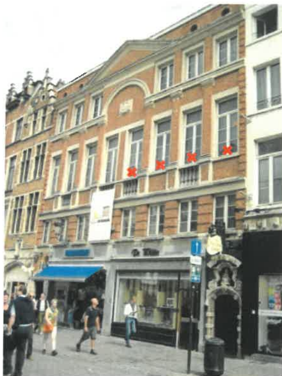
Façade principale indiquant l'emplacement des futurs garde-corps © Urban.brussels
