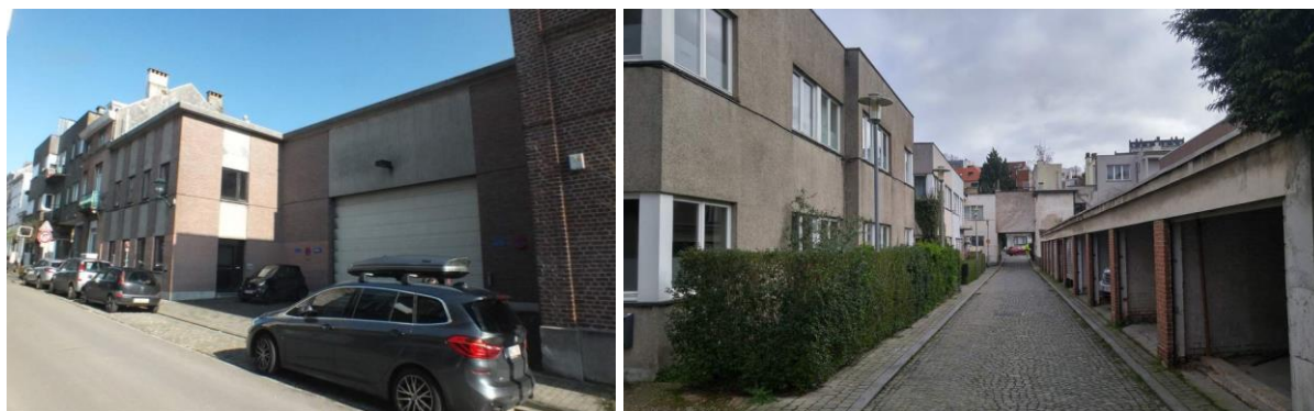
A gauche: entrepôt de 1978, parcelle n°56. Photo CRMS
