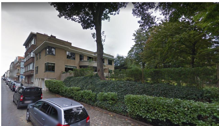
Vue sur la villa depuis l'avenue du Val d'Or © Google Maps
