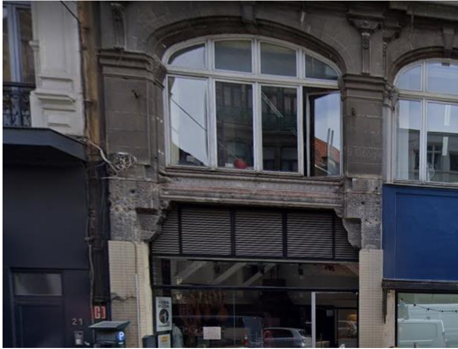
Au n°19, la dernière travée de l'immeuble et sa vétusté... (©Google maps, 2019)
