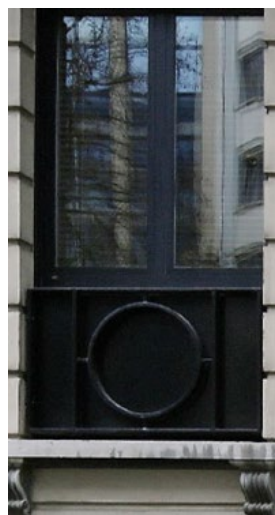
Châssis métallique existant
