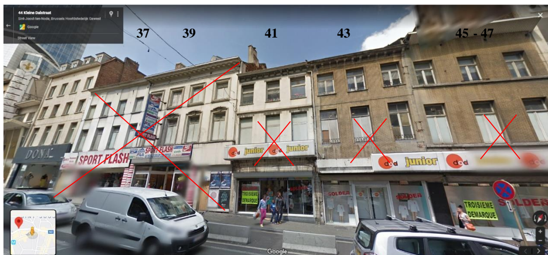
Séquence urbanistique néoclassique de la chaussée de Louvain concernée par les demandes en cours sur l'îlot
