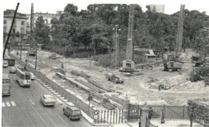
Chantier de construction de la station « Parc » (archives SSE)
