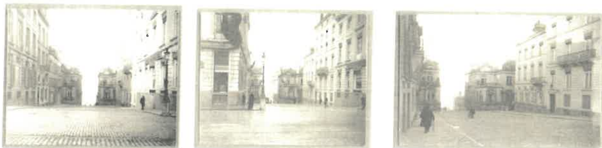
Photos montrant les trois immeubles tels qu'ils apparaissaient avant leur profonde transformation de 1920 (extrait du dossier)
