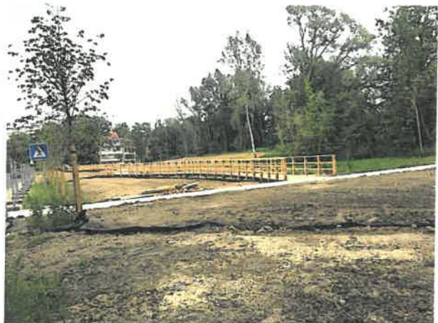
Fig. 5 : Le « Jardin de pluie » le long de la chaussée de Saint-Job
