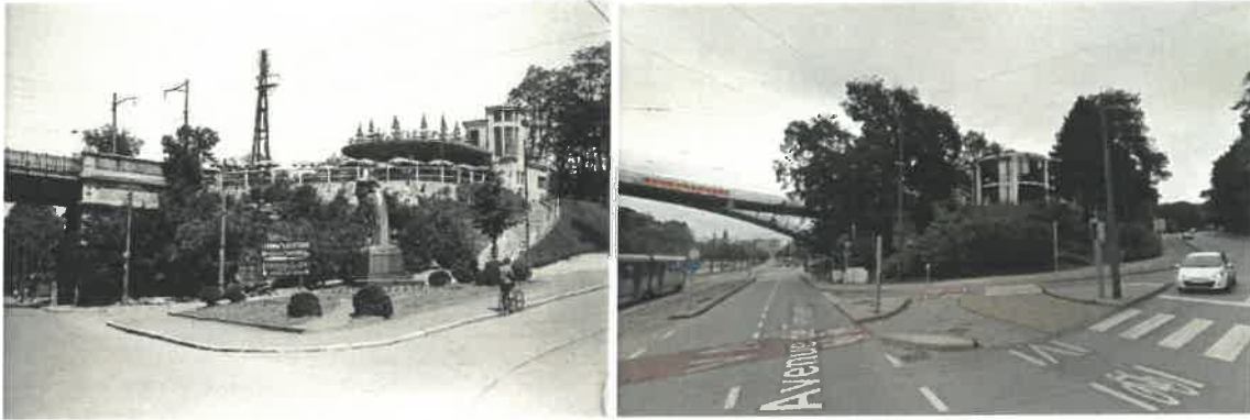
A gauche : Vue sur le talus et la halte en 1935. IRPA A droite : Vue sur le talus et la halte en 2019. Google Street View.
