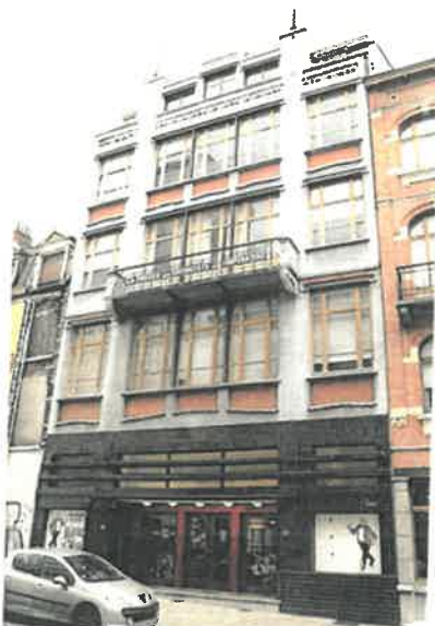
Façade rue des Sables 33-35 © urban.brussels
