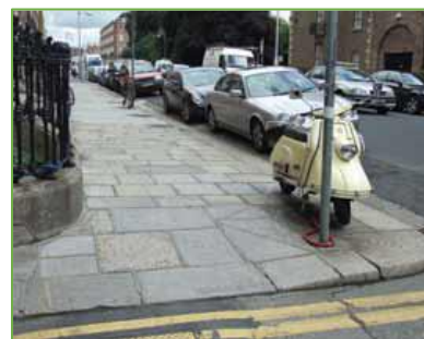
Figure 68 : Dublin, trottoir aménagé en pente douce accessible pour les personnes à mobilité réduite. (Photographie Irish National Disability Authority)
