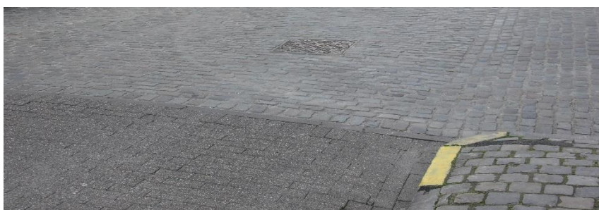
Une partie de la rue du Grand Hospice, partiellement couverte de dalles de béton, a été repavée. Le revêtement est respectueux du patrimoine et confortable à l'usage.
