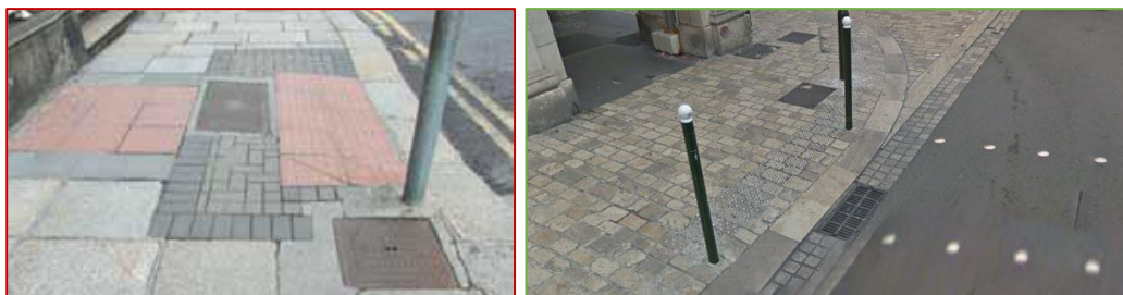
Figure 70 : pavages podotactiles à Dublin et Orléans
