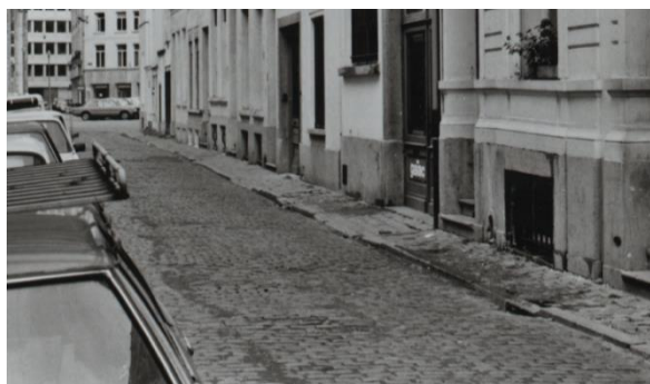
La rue du Béguinage en 1981 (A.V.B., F.I., C-15958, détail.)
