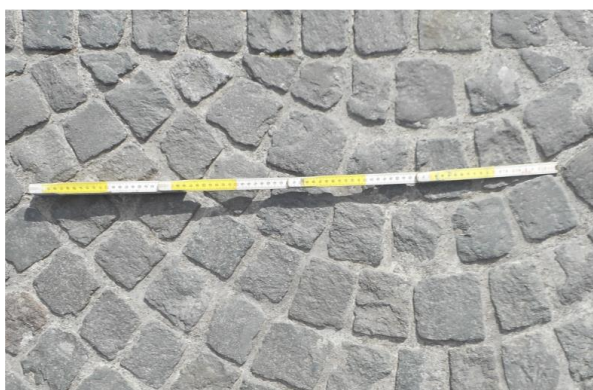
Mesure des revêtements de sol
