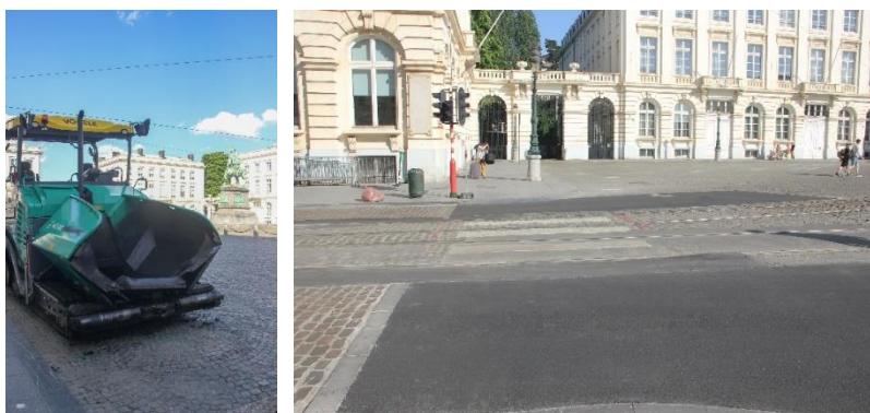
Figure 33 : asphaltage partiel de la place Royale, 2019.
