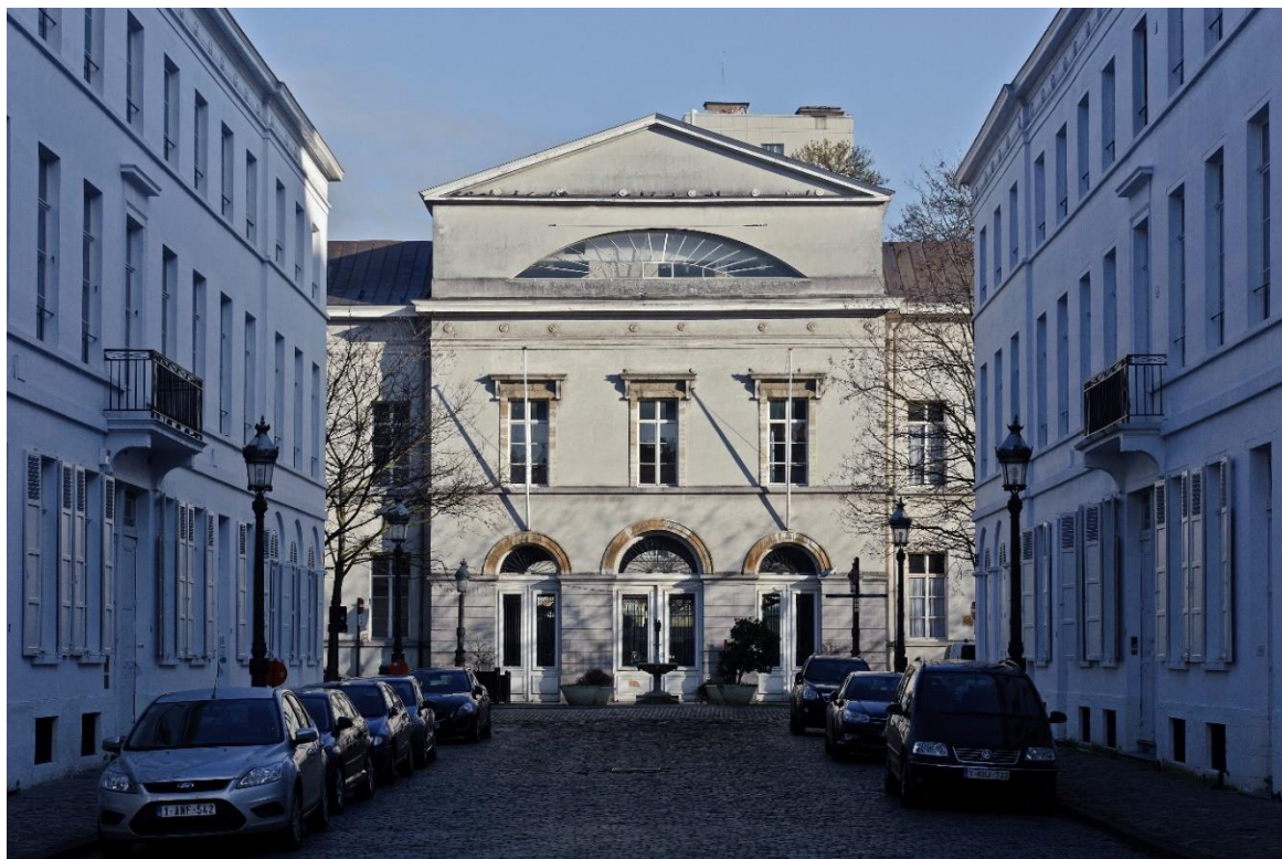
Figure 40 : la façade principale du Grand Hospice et la rue de l'Infirmerie, conçues par Henri Partoes (Urban.Brussels, centre de documentation).
