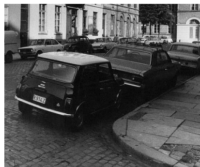
Le trottoir d'origine de la rue de l'Infirmierie (Photographie IRPA, 1975, détail).
