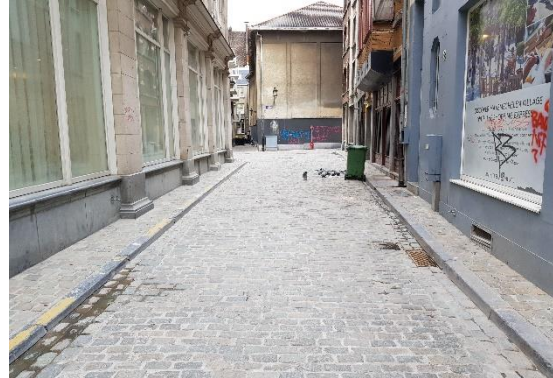
Figure 75 : la rue du Marché aux Peaux a été rénovée dans le respect de sa forme urbaine acquise au XIX e siècle. Le trottoir historique, un des rares exemples de trottoir des années 1840 préservé, a été maintenu et intégré au projet. (Photographie C. Loir).
