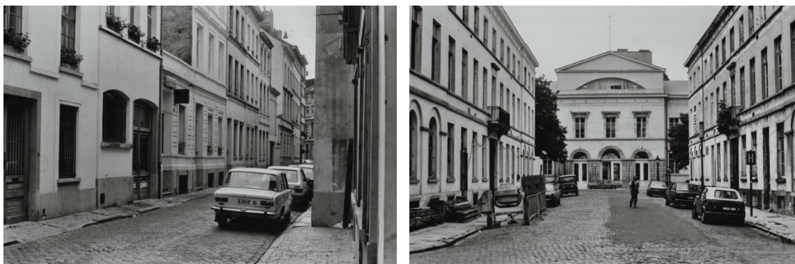
Figure 53 : le quartier du Grand Hospice en 1981 (A.V.B., F.I., C-15957 et C-15990.)
