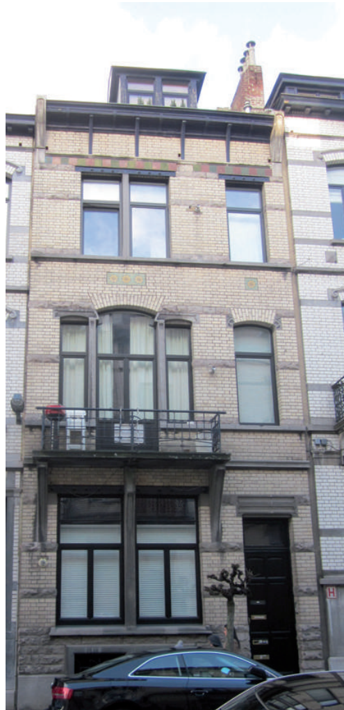
Maison unifamiliale bourgeoise entre murs mitoyens : façade sur rue
