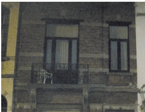
Exemple de façade éclectique jalonnée de ponts thermiques par usage de pierre bleue
