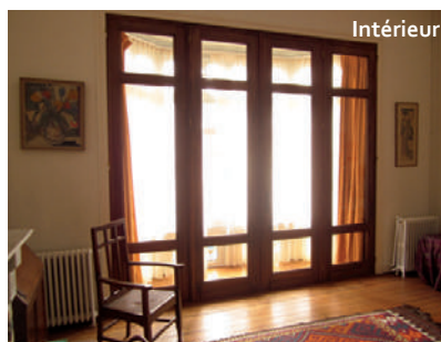
Porte fenêtrée installée comme coupure thermique vis-à-vis de la paroi froide de la bretèche
