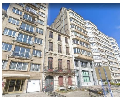
Vue du bien en 2020. ©Google Street View
