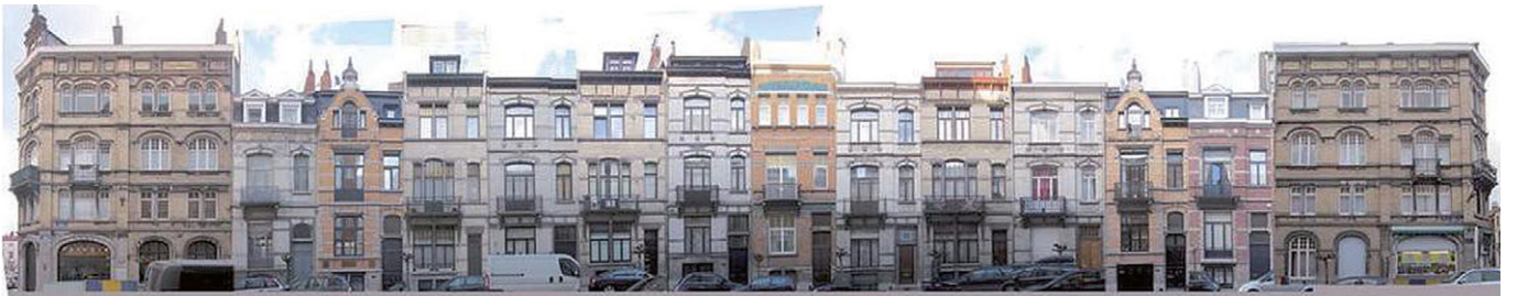
Images extraites de l'étude de l'APUR sur la performance énergétique des bâtiments de logements existants à Bruxelles (2013)
