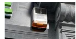
Montage de la nouvelle enseigne de téléphone et boîtier d'alarme installé
