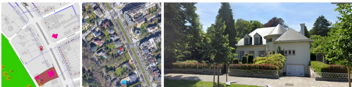
Localisation du projet (© Brugis, ©Streetview), villa existante concernée par la démolition (photo jointe à la demande)
