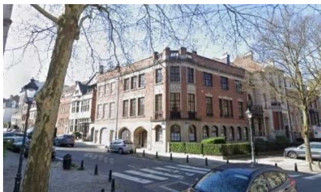
Vue de l'immeuble. ©Google Street View
