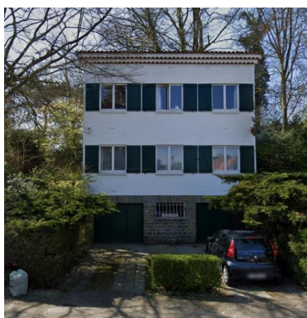
Vue de la façade avant du bien. ©Google Street View
