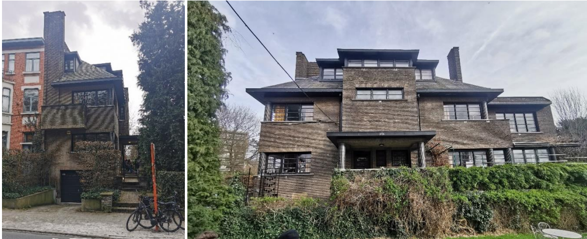
Vues des façades à rue et latérales (©CRMS, 2023)
