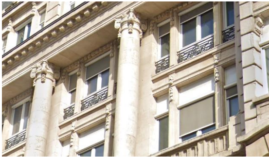
Division actuelle des châssis et garde-corps en feronnerie (© Google Streetview)
