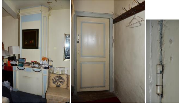
Éléments intérieurs présents dans la maison à rue (images issues de l'État de référence réalisée en 2024 (©urban.brussels)
