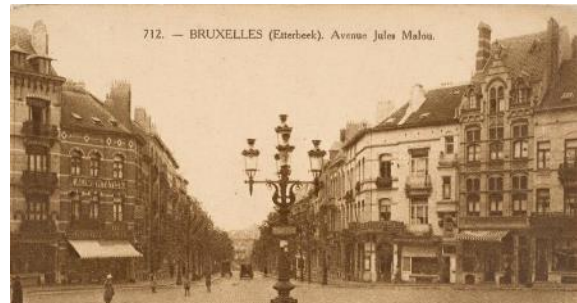
Carte postale ancienne (avant 1920 avec vue partielle (à droite) de la maison. Source : bruciel.brussels 1
