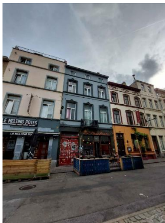
Façade avant (Photo extraite du dossier de demande)
